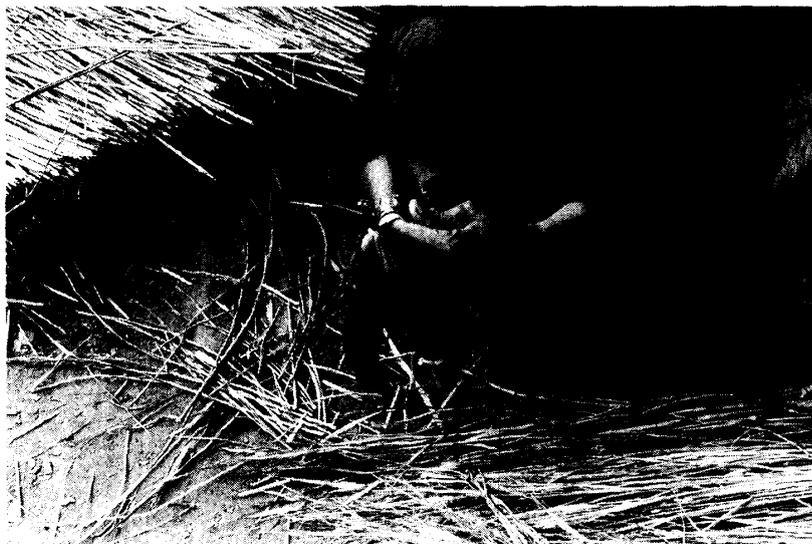
写真5 中央上部に軽く切れ込みを入れ、そこを中心にして折り曲げる
