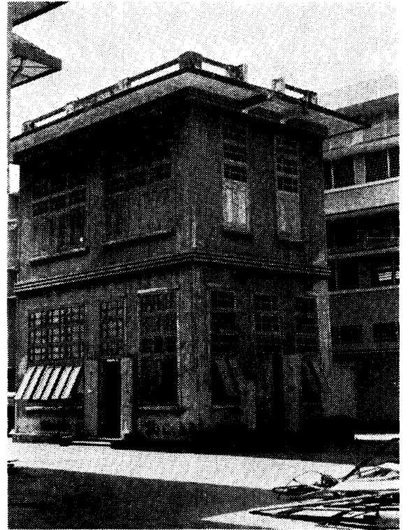
写真3 陸地測量部構内の重力室 (測点は1階左手)
