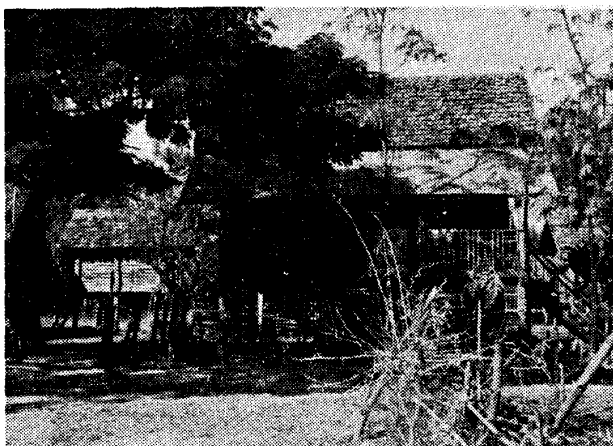
写真2 木で葺いた屋根
